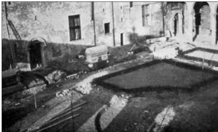
Marzo 1933 - Lavori di riorganizzazione degli spazi del cortile del Palazzo dei Diamanti.
