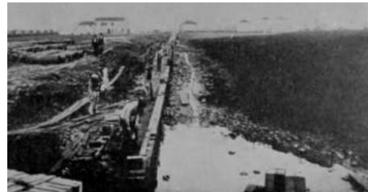
Ferrara 1938, lavori nella zona industriale.
